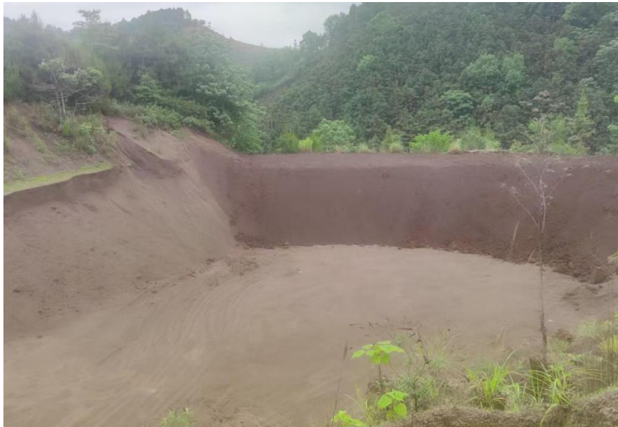
插图4.1-6 排土场占损现状
