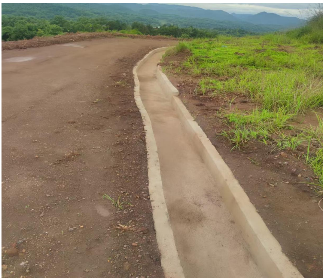
照片15 矿山修筑水泥截排水沟，总长约873m
