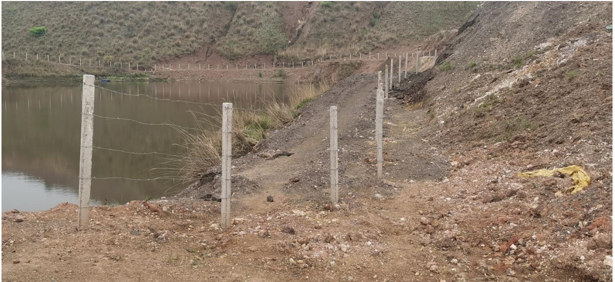
照片13 矿山水坑边缘处设置的安全防护栏现状照片，总长约400m
