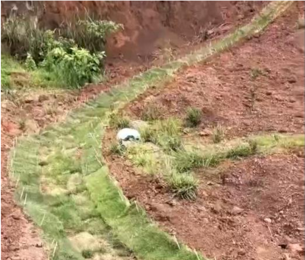
照片14 矿山修筑生态排水土沟，总长约758m
