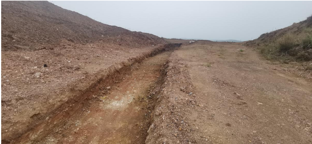
照片11 复绿区1及复绿区4附近 排土沟（土沟）现状照片，长度151m
