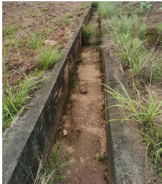
照片12 矿山GY01选厂旁设置的截排水沟现状照片，总长约410m
